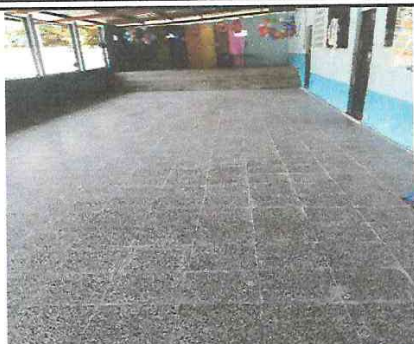
Foto 1: Instalación completa de piso de granito en corredor
