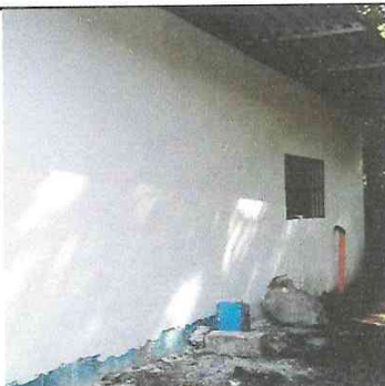
Foto 4: Repello exterior terminando
