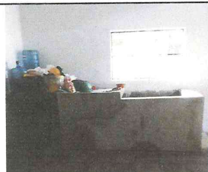
Foto 3: Pila y lavaderos terminados, repello interior
