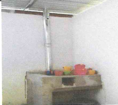
Foto 2: Estufa rural con su chimenea terminada
